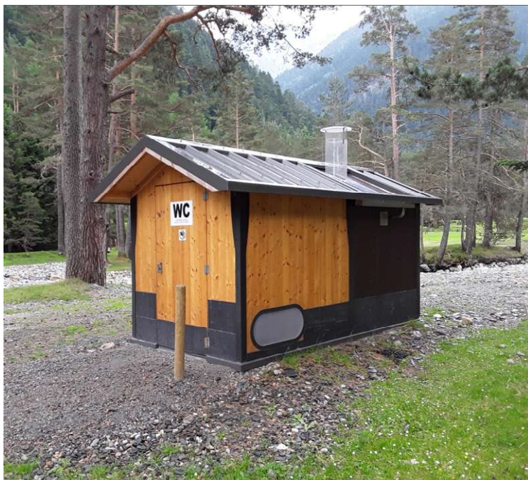
Photo 1 : Les toilettes sèches de Frédancon
